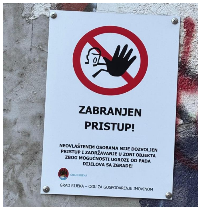
Slika 6. prikaz zabrane pristupa na zapadnom zidu H-objekta, vlastita fotografija
